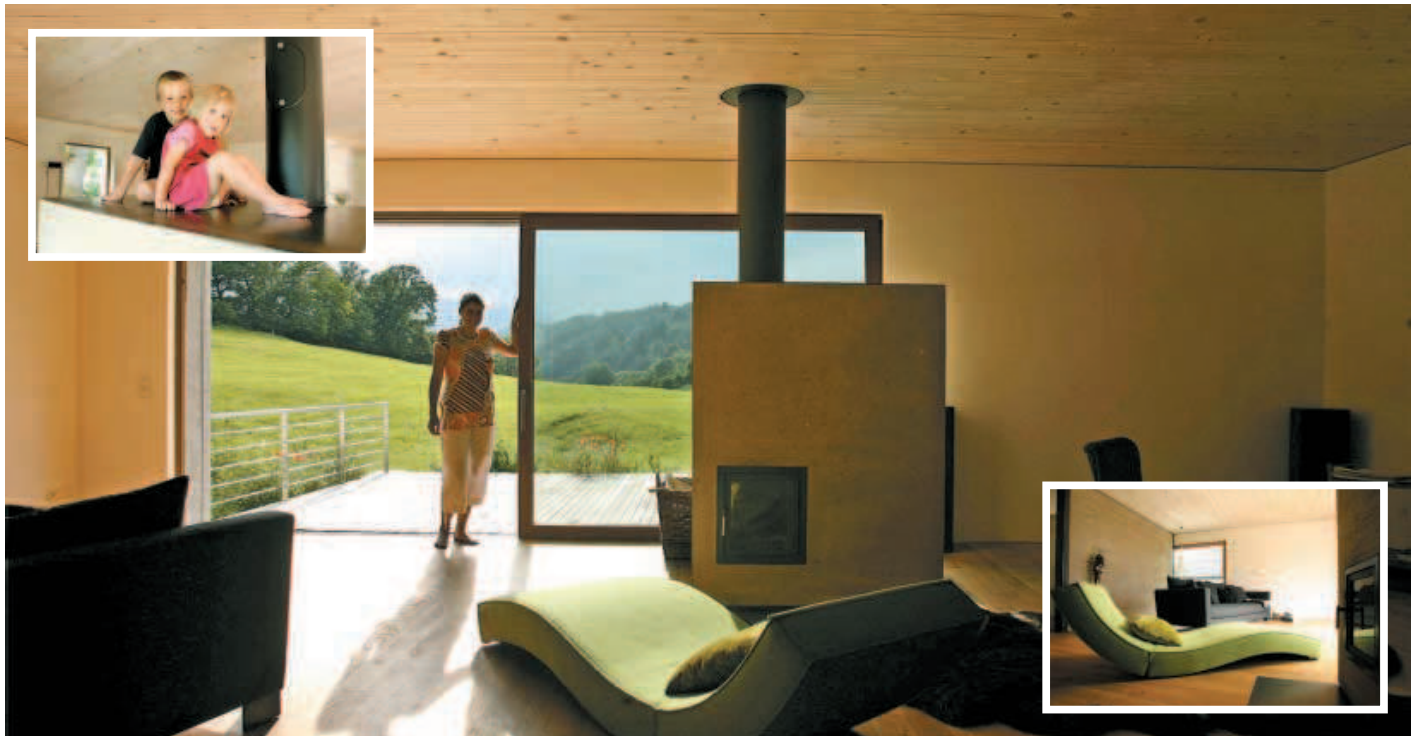
Lehmwände und Lehmkachelofen wurden aus dem eigenen Baustellenhubmaterial angefertigt.
