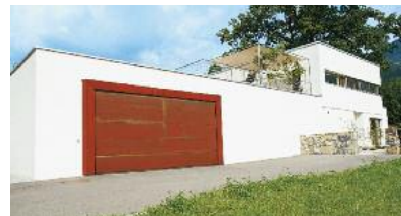
■ Besucher der Praxis geleitet der lang gestreckte Südwestflügel auf dem Weg zum Eingang.
