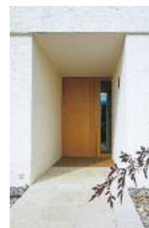
■ Reiner Kalkputz kam für die Fassadengestaltung zum Einsatz.
