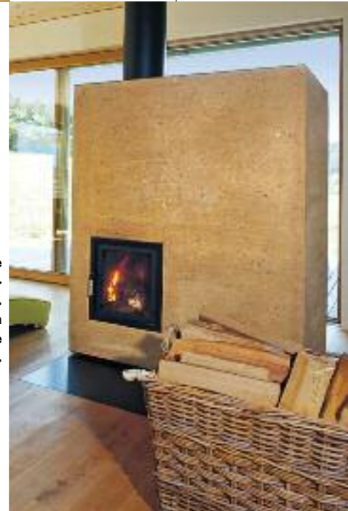
|| Lehm aus der Baugrube ist auch der Hauptbestandteil der Ofenhülle. Der Ofen wurde am Stück geliefert, wie die Stampflehmwand.
