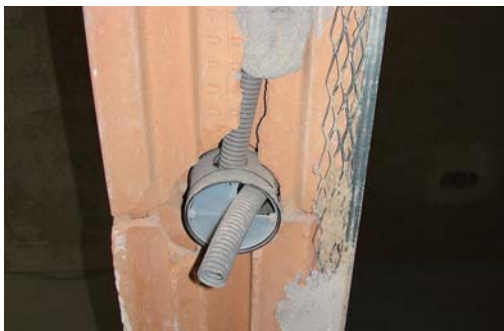
レンガ造の間仕切り壁に埋め込まれた設備配管
