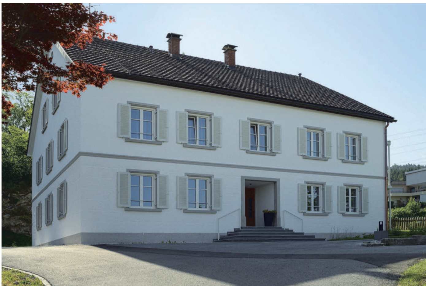
Vorzeigeprojekt. Die Sanierung ist energetisch wie optisch gelungen – auch dank der neuen Fenster mit Sprosse entsprechend historischer Fotografien der Jahrhundertwende.
